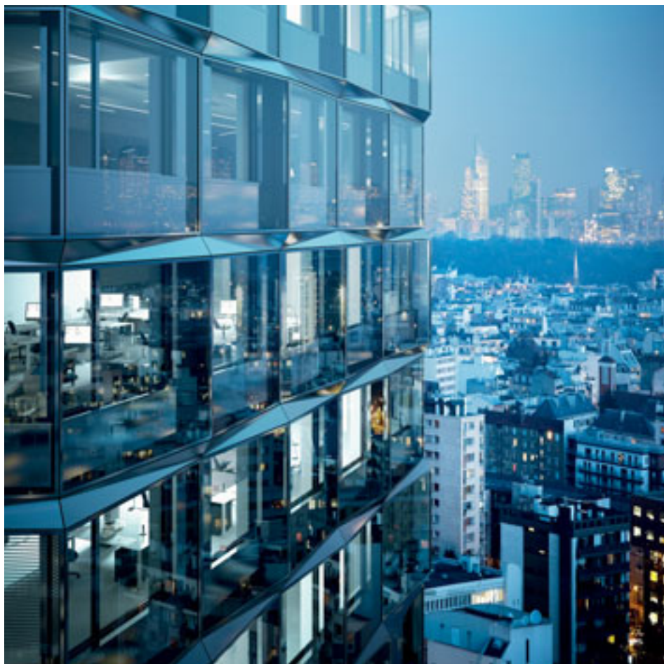
FRANCE : Rénovation des tours du Pont de Sèvres à Boulogne-Billancourt dans le cadre du projet Citylights.
