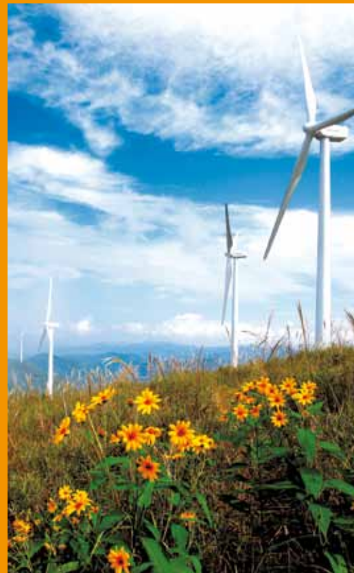
The Yeong Yang wind farm in South Korea
