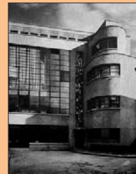
L'atelier Barillet restauré
